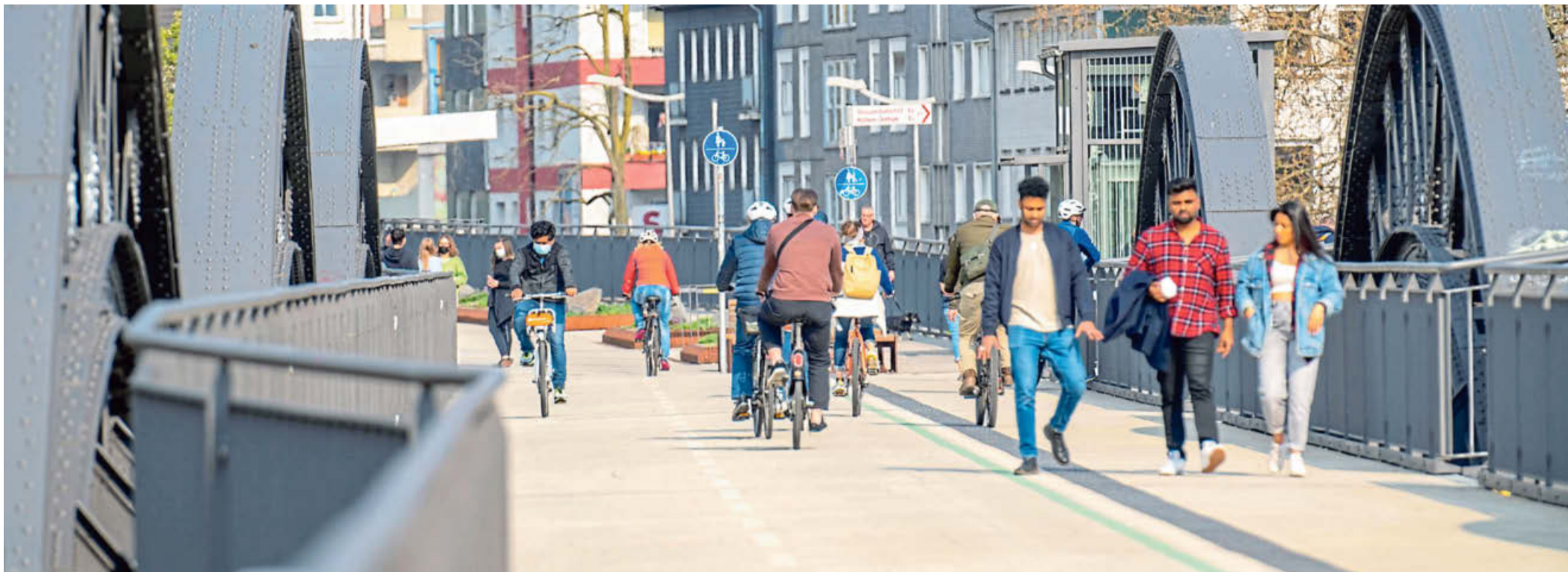
Der Radschnellweg RS1 – einer von sieben geplanten in NRW – ist in zwei Abschnitten bereits fertig. Hier fahren Radler in Mülheim an der Ruhr über eine ehemalige Eisenbahnbrücke. Foto: Imago
