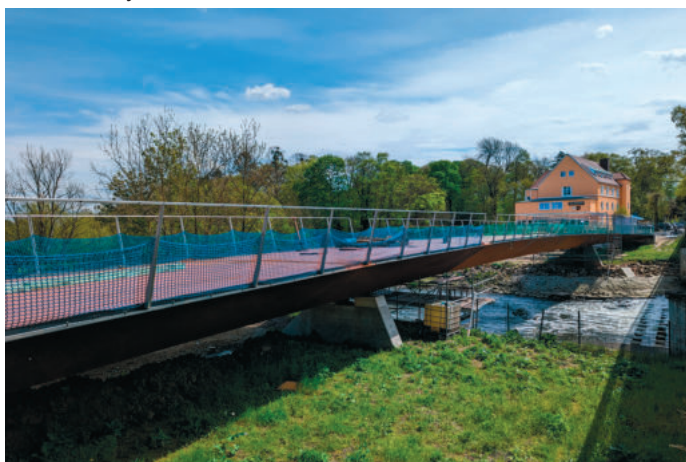
Neue Sielbrücke in Werste
